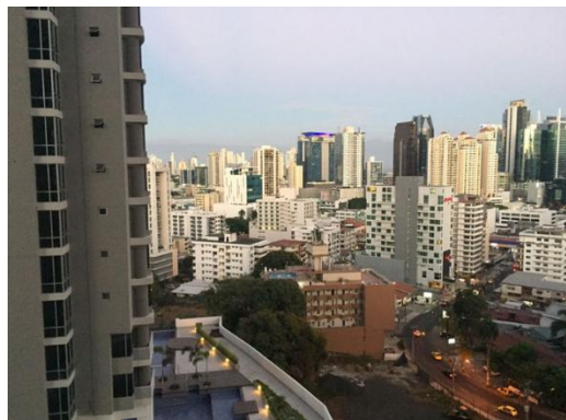
Figura 4. Imagen construcciones en El Cangrejo
